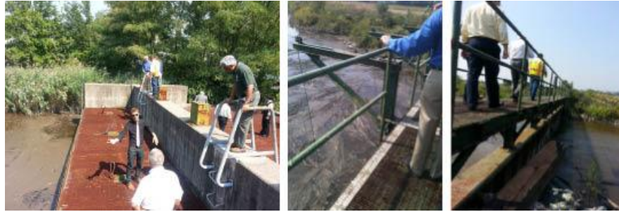
Figura 3-1: Inspección física de la infraestructura de reducción de riesgo existente. Equipos asignados por el Departamento de Protección Ambiental de New Jersey han buscado catalogar el impacto del Huracán Sandy sobre bermas, compuertas de marea y otra infraestructura de reducción de riesgo existente. La inspección física es una parte clave de la evaluación del Estado de las condiciones actuales de medidas para identificar las reparaciones necesarias así como las oportunidades para mejorar las medidas existentes para abordar sucesos climáticos extremos futuros y maximizar la inversión federal.
