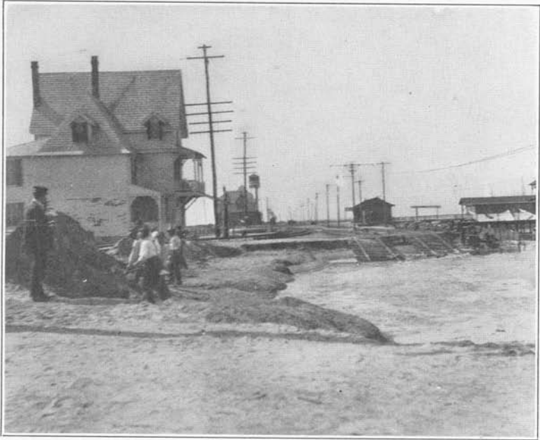
Fig. 1. Sink hole at Longport, N. J.
