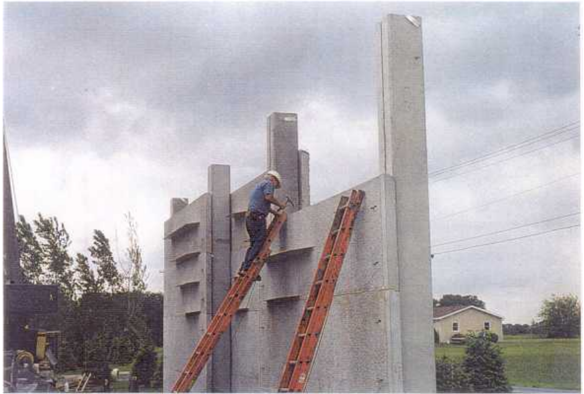
Fig. 21 Checking panel edge for debris.
