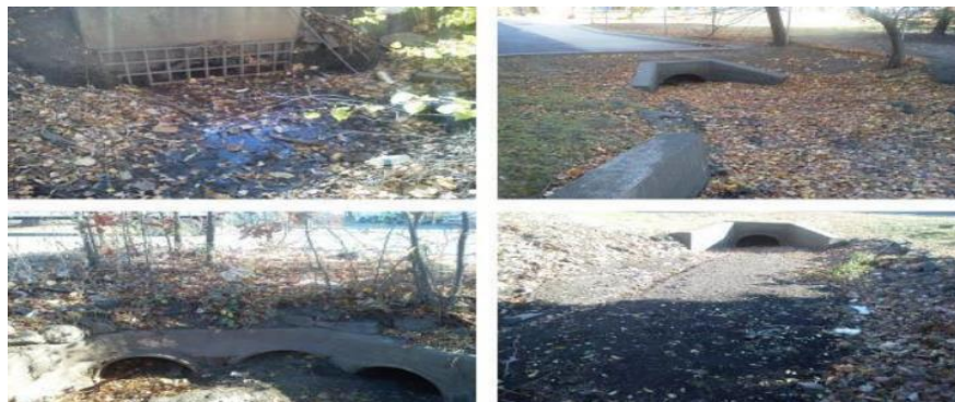
Fig. 4.2: Sistemas de drenaje en Moonachie y Little Ferry. Al tratar los problemas de drenaje podrían surgir oportunidades de inversión de bajo costo para aumentar la resiliencia de Nueva Jersey ante las inundaciones. Por ejemplo, los «cuellos de botella» en los sistemas de drenaje, la acumulación de escombros y la vegetación exuberante pueden exacerbar en conjunto el impacto de las inundaciones y las marejadas ciclónicas en las comunidades. Además, algunos sistemas de drenaje, construidos en forma fragmentada en los últimos dos siglos, nunca se mapearon. Por ende, Rutgers University evalúa la posibilidad de reducir las inundaciones con mejoras menores al drenaje en la región de Moonachie y Little Ferry (véanse las fotos).
