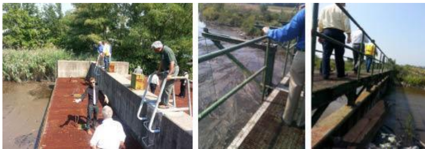
Figura 3-1: Inspección física de la infraestructura de reducción de riesgo existente. Equipos asignados por el DEP de New Jersey han buscado catalogar el impacto del huracán Sandy sobre bermas, compuertas de marea y otra infraestructura de reducción de riesgo existente. La inspección física es clave en la evaluación del Estado sobre las condiciones actuales de las medidas, para poder identificar las reparaciones necesarias así como las oportunidades para mejorar las medidas existentes para abordar sucesos climáticos extremos futuros y maximizar la inversión federal. Fuente: Estado de New Jersey en colaboración con el Instituto de Tecnología de New Jersey.
