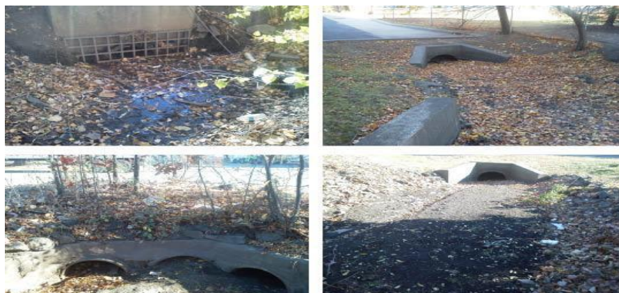
Figura 3-2: Sistemas de drenaje, Moonachie/Little Ferry. Al abordar los problemas de drenaje se podrán ofrecer oportunidades de inversión a bajo costo y aumentar la resiliencia de New Jersey a las inundaciones. Por ejemplo, los cuellos de botella en los sistemas de drenaje, la acumulación de residuos y el crecimiento excesivo
