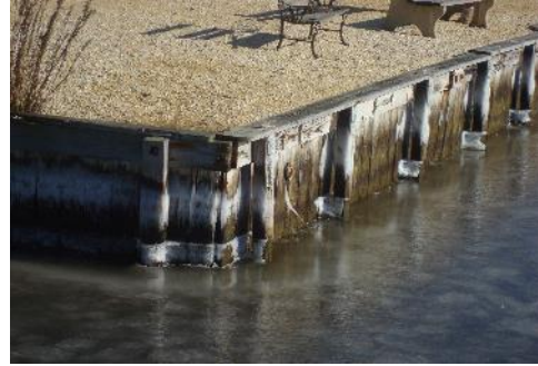
(d) Wood Bulkhead
