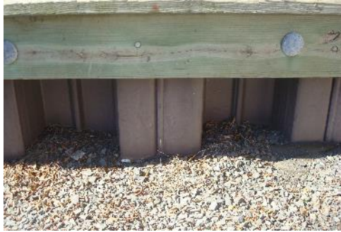
(d) Steel Bulkhead Cap
