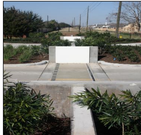
(d) Roadway Floodgate
