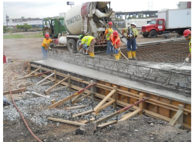
Concrete pour for the south filter press pad
